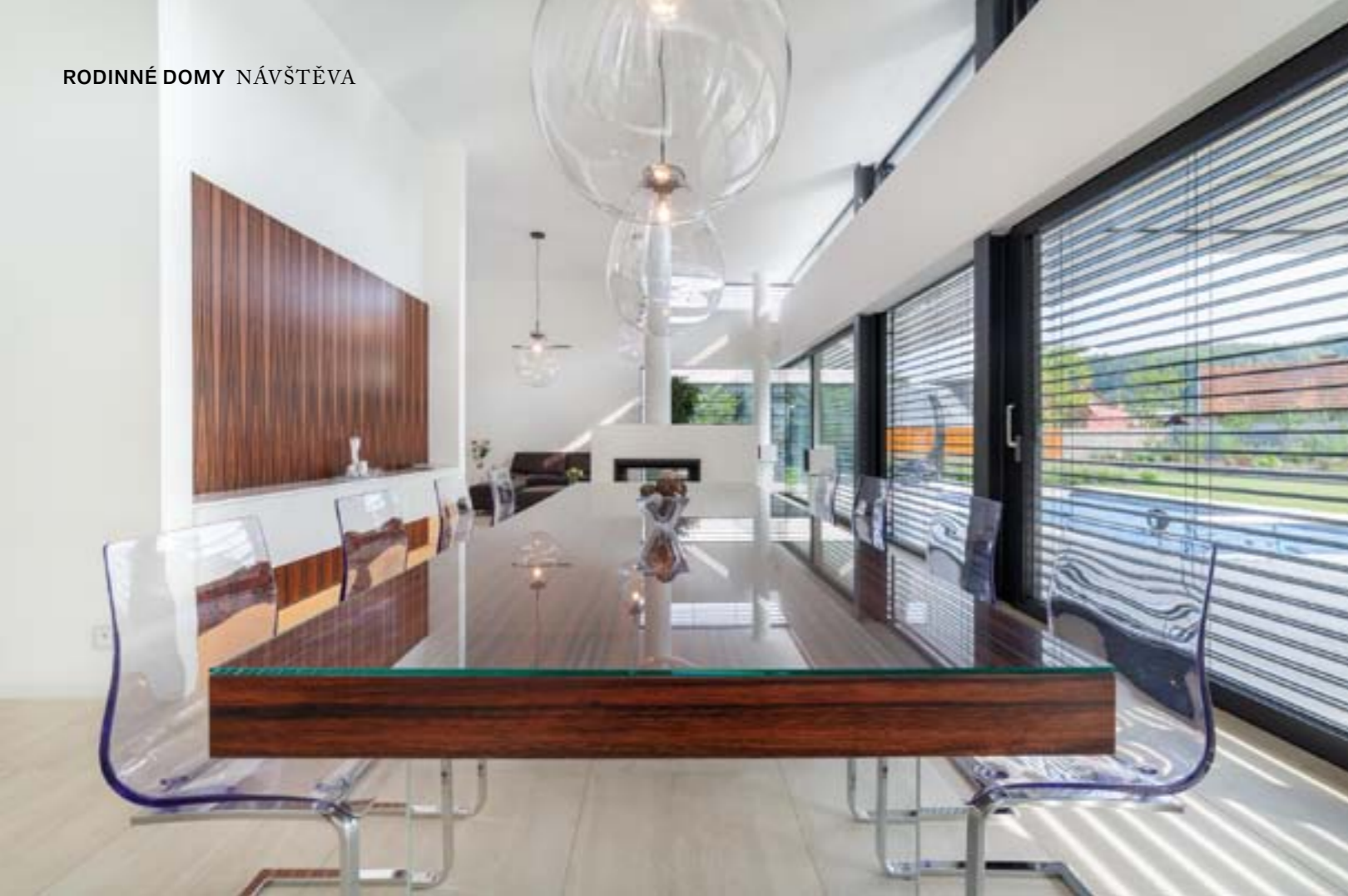
Prosklenou fasádu tvoří střídaně pevně zasklené a posuvné plochy (zdvižně posuvný systém Schüco) o šířce 2,5 metru. Pevné části mají skryté okenní rámy, extrémně dlouhý nadokenní překlad podporují dva subtilní středové sloupky z válcovaných ocelových I profilů
